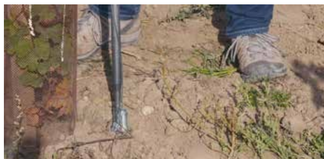
Верхнее фото. Анкер Gripple 3 и закручивающий инструмент Нижнее фото. Анкер Gripple 3, спущенный на землю
