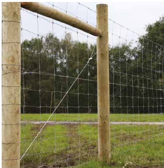
ФРАК – установлен как крепление на H-образный столб
