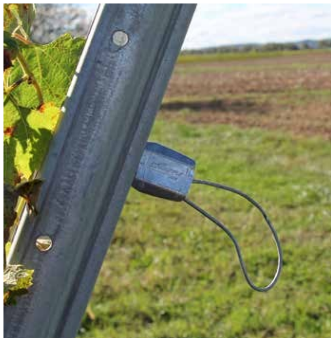
GP №1 - Установлен на металлическом столбе.
