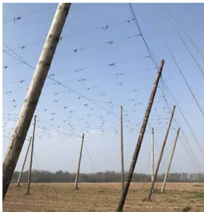
GP90 установлен на площадке с хмелем
