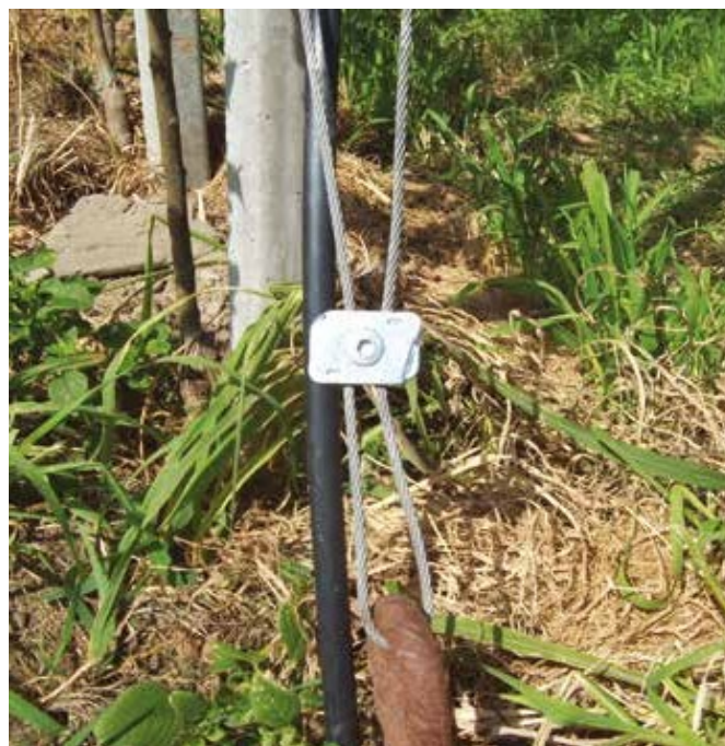
ДПАК – Установлен в форме петли с дроссельным узлом на бетонном столбе. ДПАК - Установлен в форме петли с дроссельным узлом на деревянном столбе.
