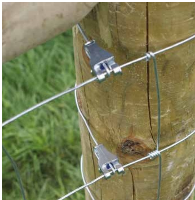
T-образная клипса 1 – установлена на скотоводческом ограждении
