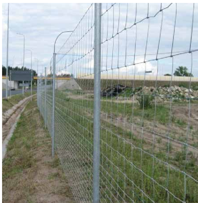
Придорожное ограждение с Комплектом для ограждения с использованием штифта
