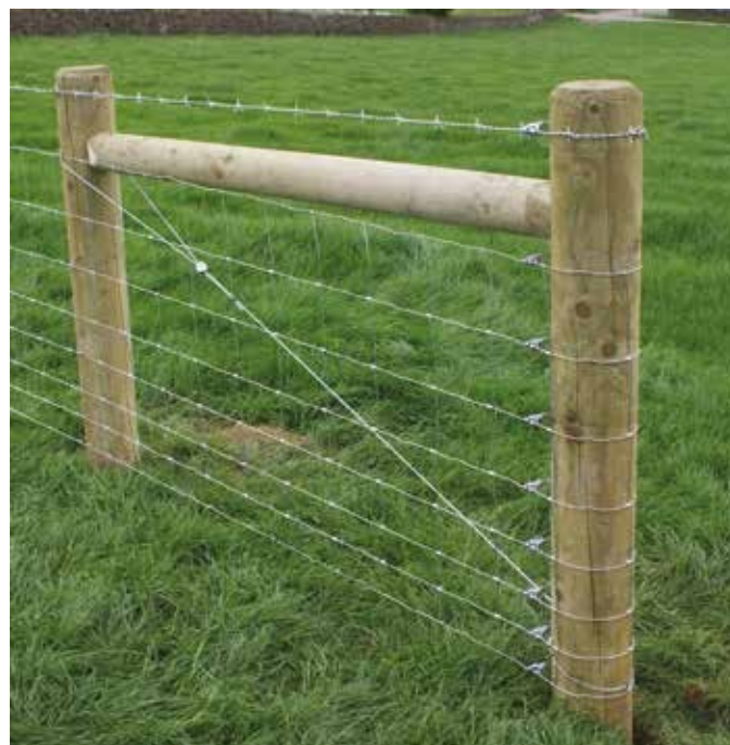
ФРАК – установлен на H-образный концевой столб
