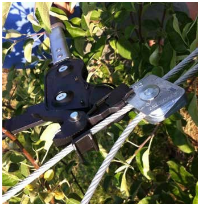
Дунаіс 6 – Натяжение с использованием подрядного инструмента.
